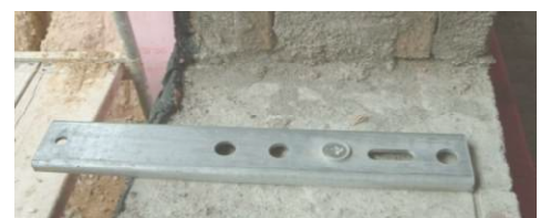
EL - Anker als Montagehilfe
