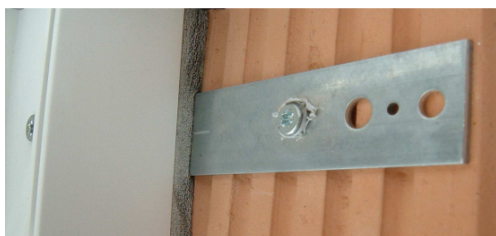
EL-Anker Flachstahl als Verstärkung des Mauerwerks
