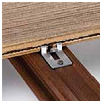
Befestigung auf WPC- Unterkonstruktion
